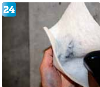
24 Rengör med klibbduk (se steg 7).
